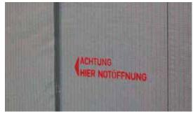
Rauchschürzensysteme dienen zur Rauchkanalisierung und Abtrennung. und dürfen, sofern bodenabschließend, nicht in Rettungswegen eingebaut werden. Sollte dennoch eine Durchschlupfmöglichkeit, z.B. für Einsatzkräfte oder Flüchtende bestehen, so kann das Smoke PROtec Rauchschürzensystem mit dieser Spezialöffnung versehen werden.
